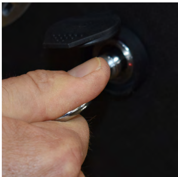
Bild 28-29. X5-tavlan öppnas genom att låsningarna låses upp med elskåpsnyckel (dvs. fyrkantsnyckel, artikelnummer: 20028, medföljer vid leverans, alternativt kan ¼ tum hylsa användas).
